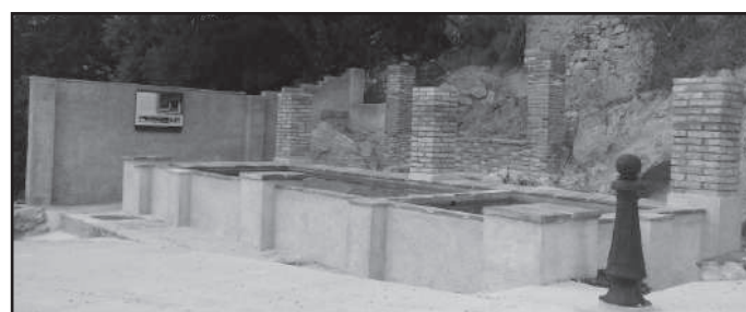
Finalització de la 2a fase d'obres.
